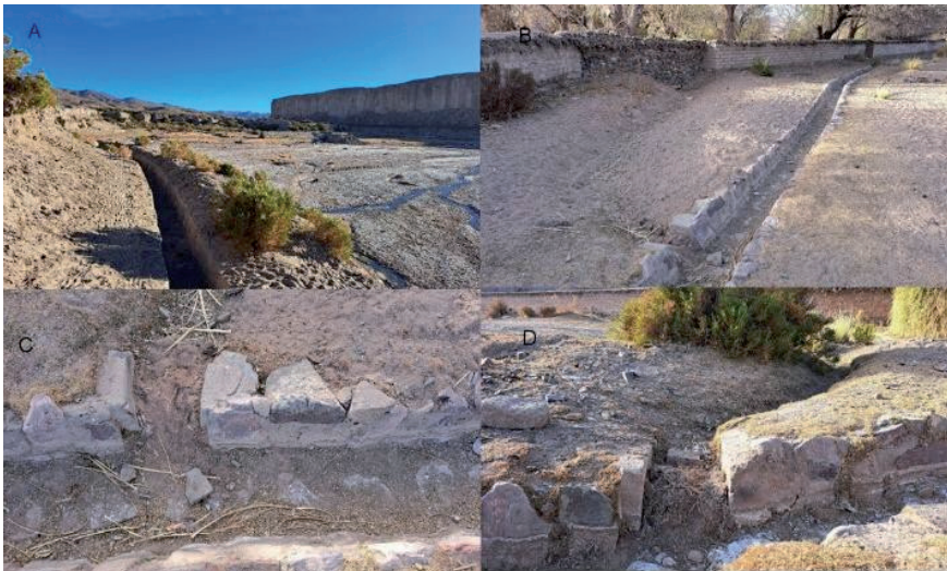
Figura 3. A) Acequia principal. B) Acequia principal. C) Compuerta acequia secundaria abierta. D) Compuerta acequia secundaria cerrada con tierra.
